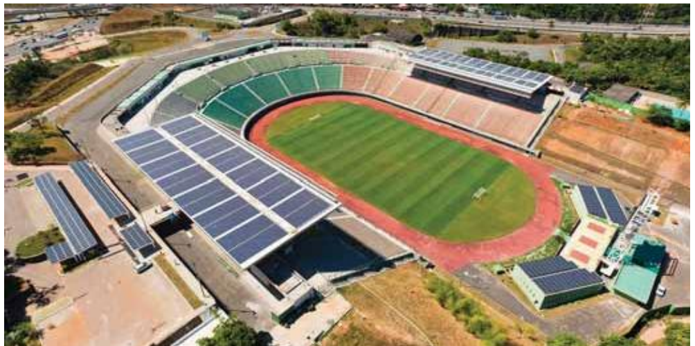
Credit: Gehrlicher Solar.
