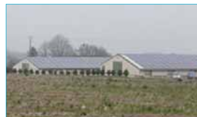
Solar Diffusion plant in Bretagne.
